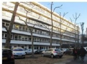
Façade A sur cour
