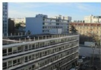
Façade B sur cour
