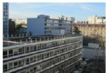
Façade B sur cour
