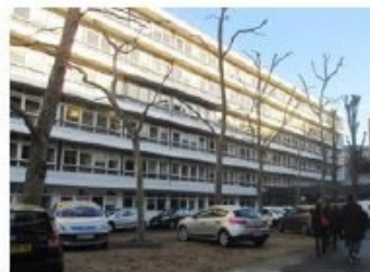
Façade A sur cour
