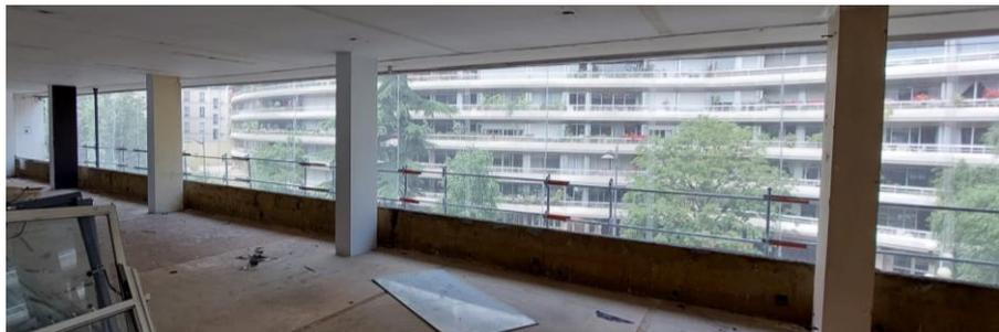
La démolition des façades a débuté avec la mise en place au préalable des gardes-corps et des filets de protection :
