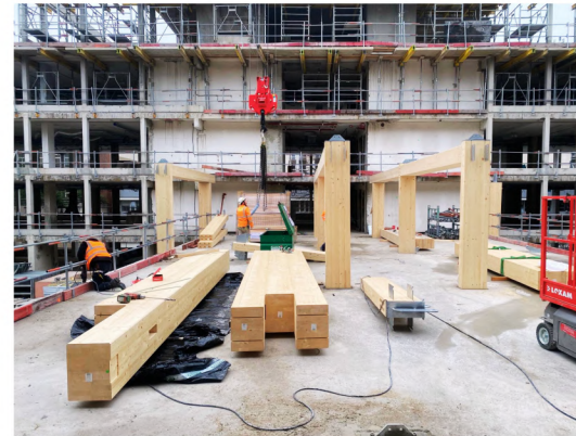
Structure bois du bâtiment D
