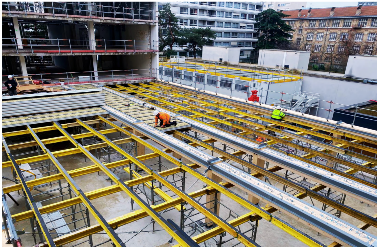
Construction du bâtiment E
