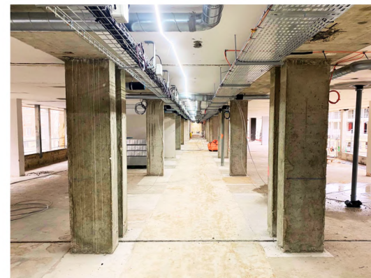
Curage du bâtiment A
